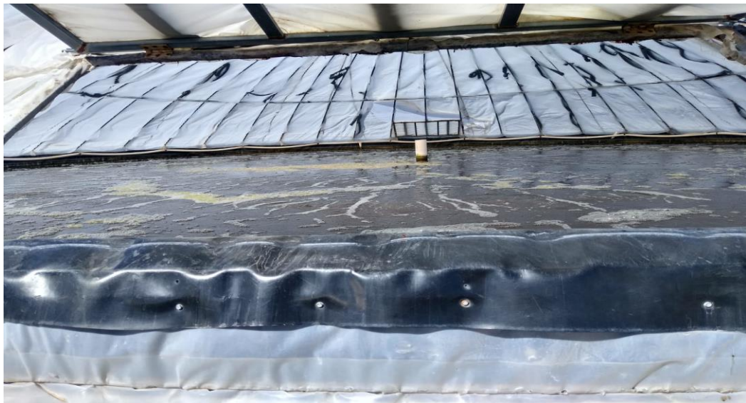
Ilustración 19. Tina de geomembrana Acuícola Santa Rosa
